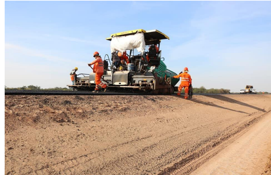
Extendido de capa asfáltica
