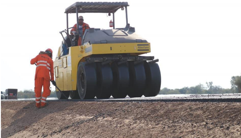
Compactación de base asfáltica
